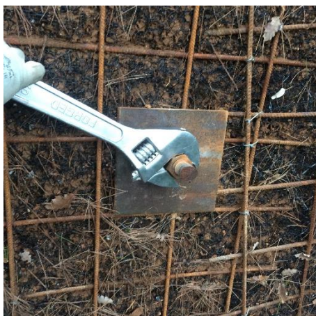
Fotografía 8 y 9: Detalle superior del paramento vertical y apriete de tuercas.
