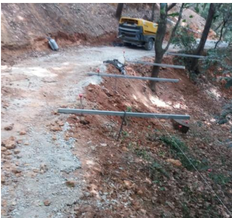
Fotografía 2 : Replanteo del muro en obra.
