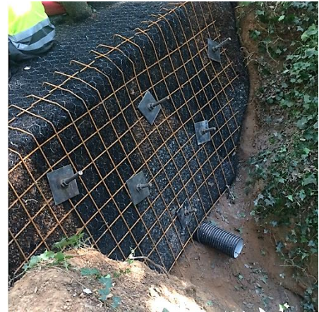
Fotografía 6 : Drenaje inferior.
