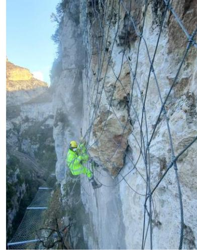
Foto 4 y 5: Trabajos en planos inclinados siempre dos puntos de anclaje.
