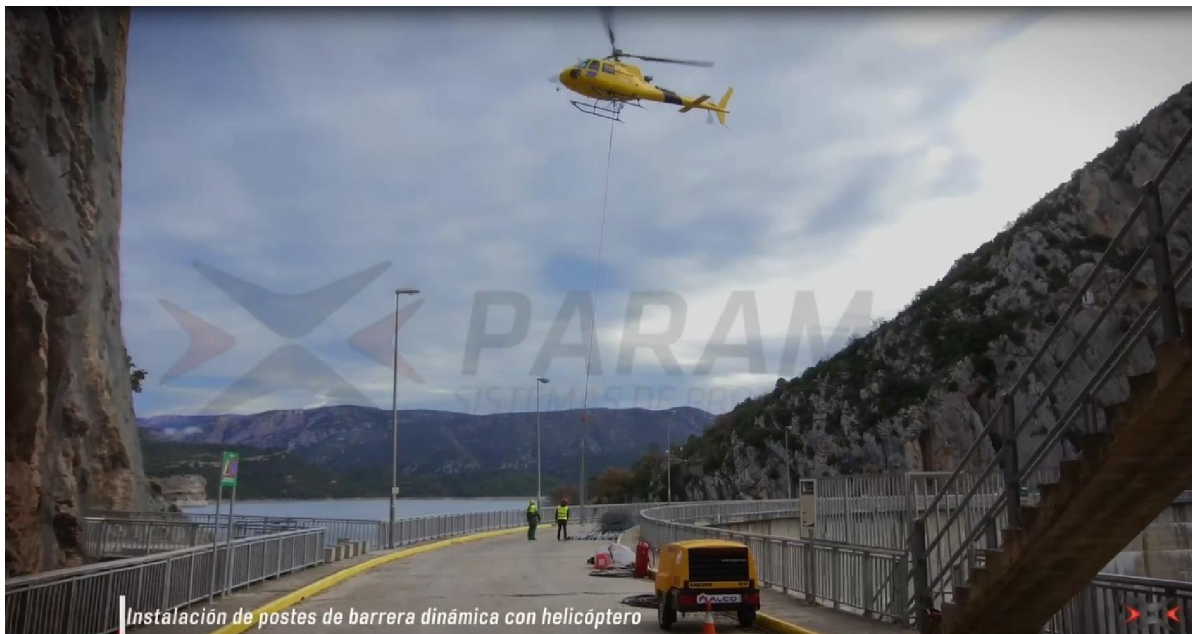
Figura 7. Izado de cargas desde la coronación de la presa.
