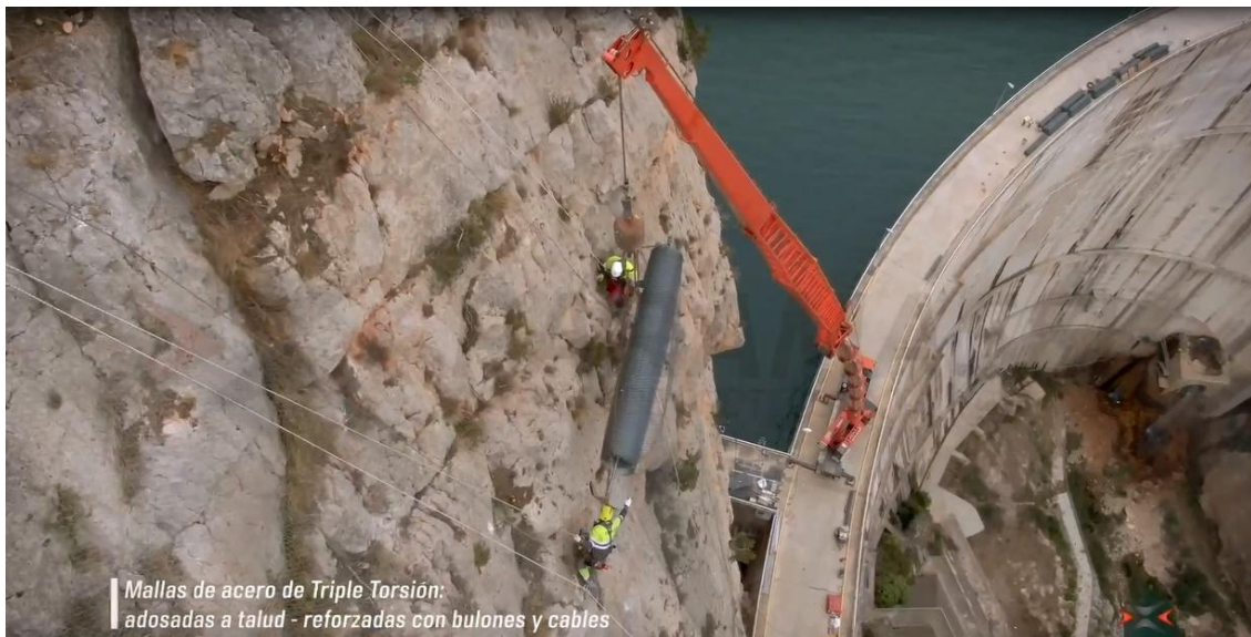
Figura 2. Vista de los trabajos de colocación de mallas por encima de la coronación de la presa.
