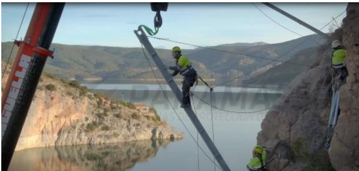
Figura 6. Colocación de elementos de pantallas dinámicas con grúa.
