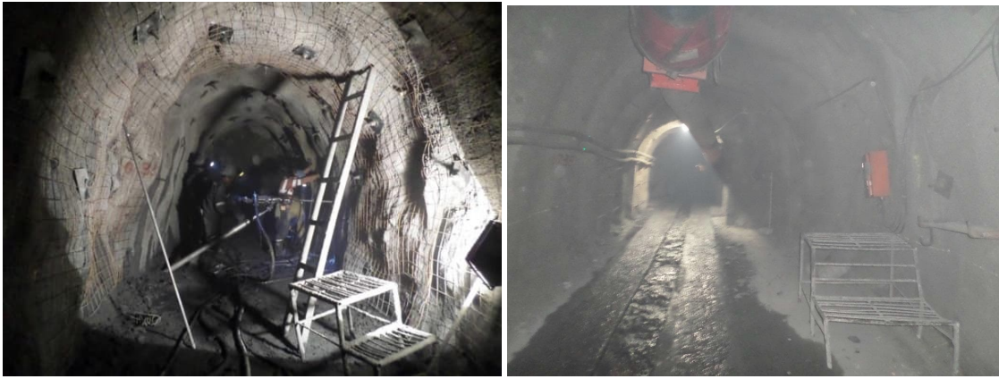
Figura 21.- Perforación del nicho F en la galería 200 A. Nicho concluido en la galería 250 A
