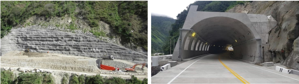
Figura 1.- Emboquilles complejos en fuertes condiciones de esviaje. Túneles de Yanango y Casahuiri (Perú)
