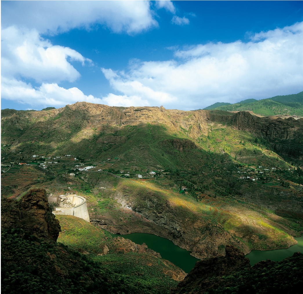
| Presa de Soria
