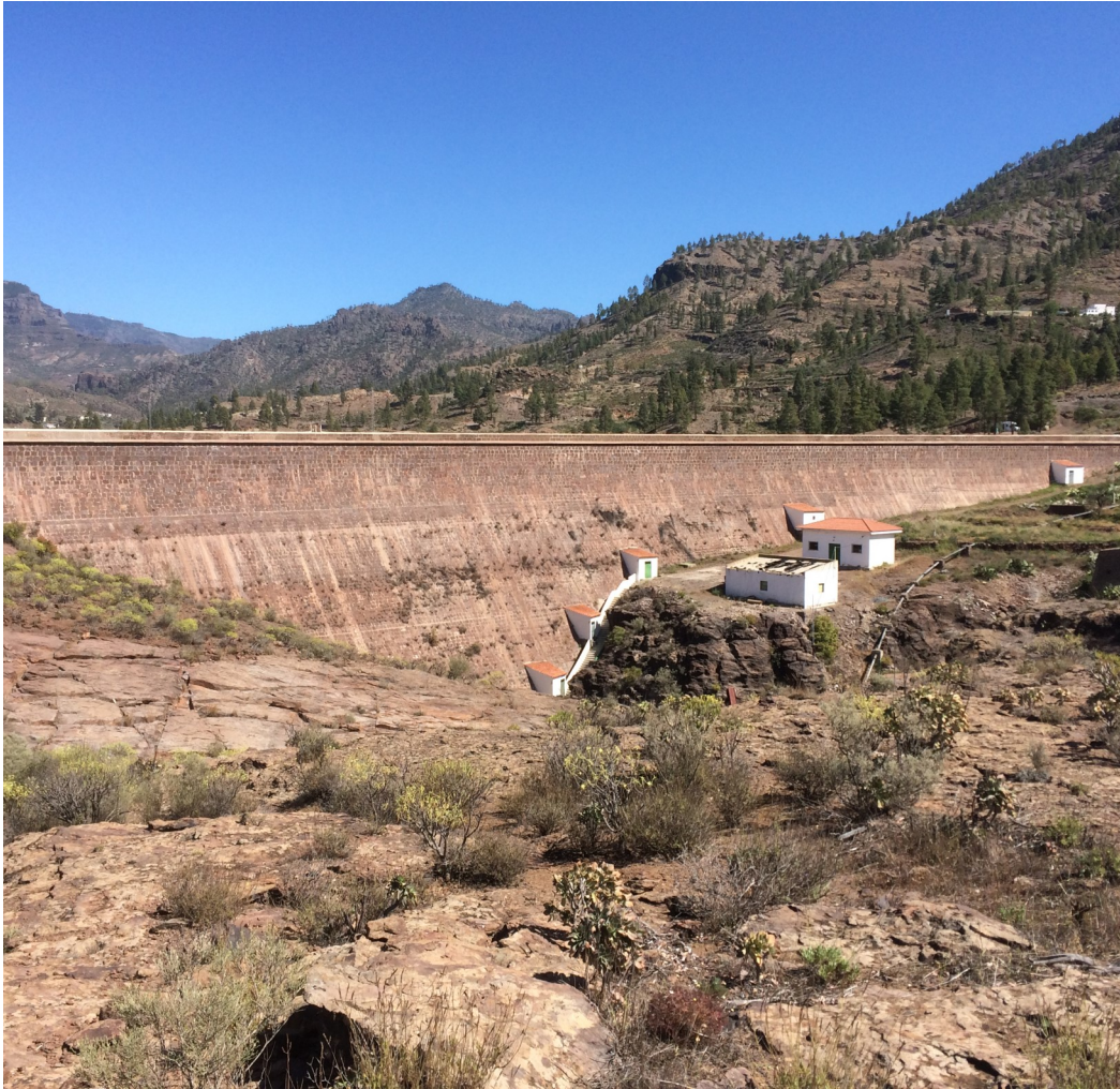
Presa de Chira
