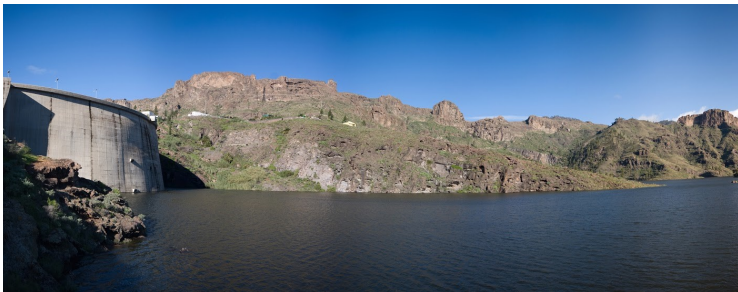
Presa de Soria
