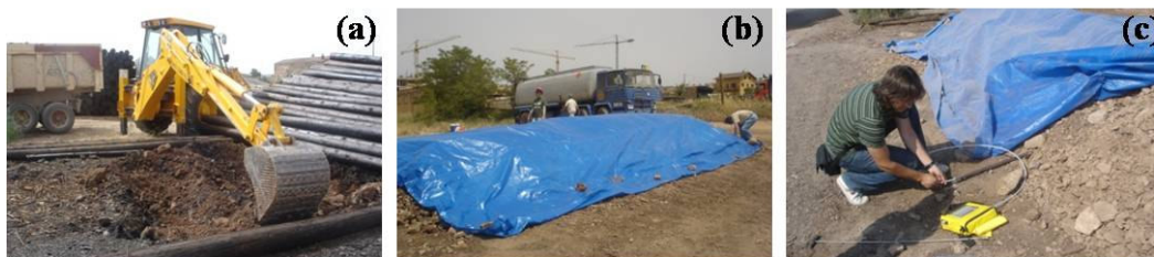
Figura 5. Construcción y control de una biopila dinámica con un suelo contaminado con creosota. (a) excavación del suelo contaminado, (b) biopila con cubierta, (c) determinación de O_2 y CO_2 .
